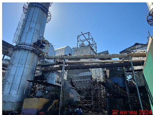
รูปที่ 7 ระบบดักฝุ่นแบบ Electrostatic Precipitator
