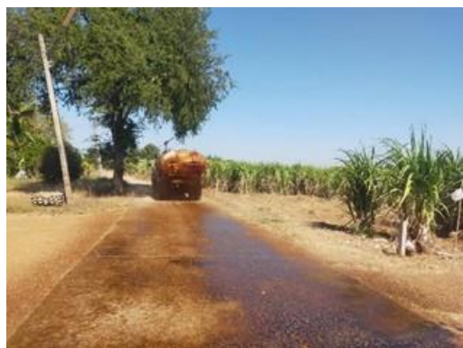
รูปที่ 9 การฉีดพรมน้ำบนถนนด้านนอกรอบพื้นที่โครงการ
