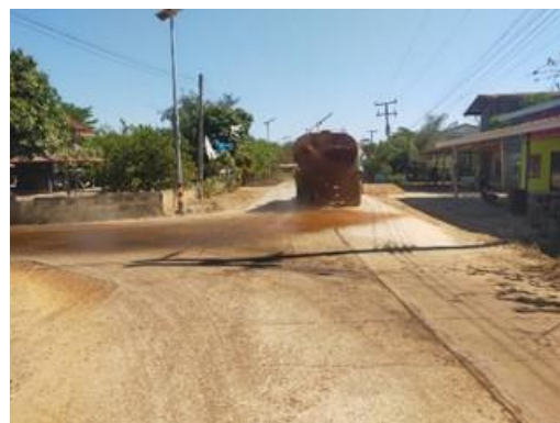
รูปที่ 9 การฉีดพรมน้ำบนถนนด้านนอกรอบพื้นที่โครงการ
